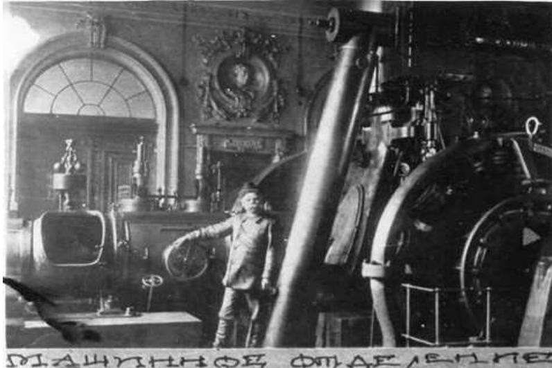
Експериментальна електростанція КПІ
