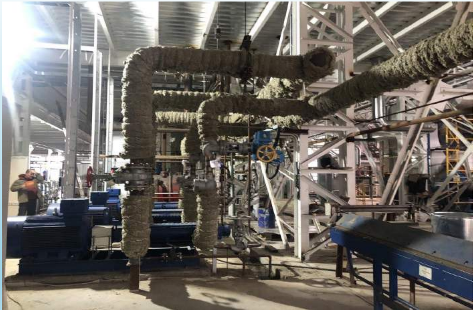
Осень 2019 года монтаж и утепление труб
