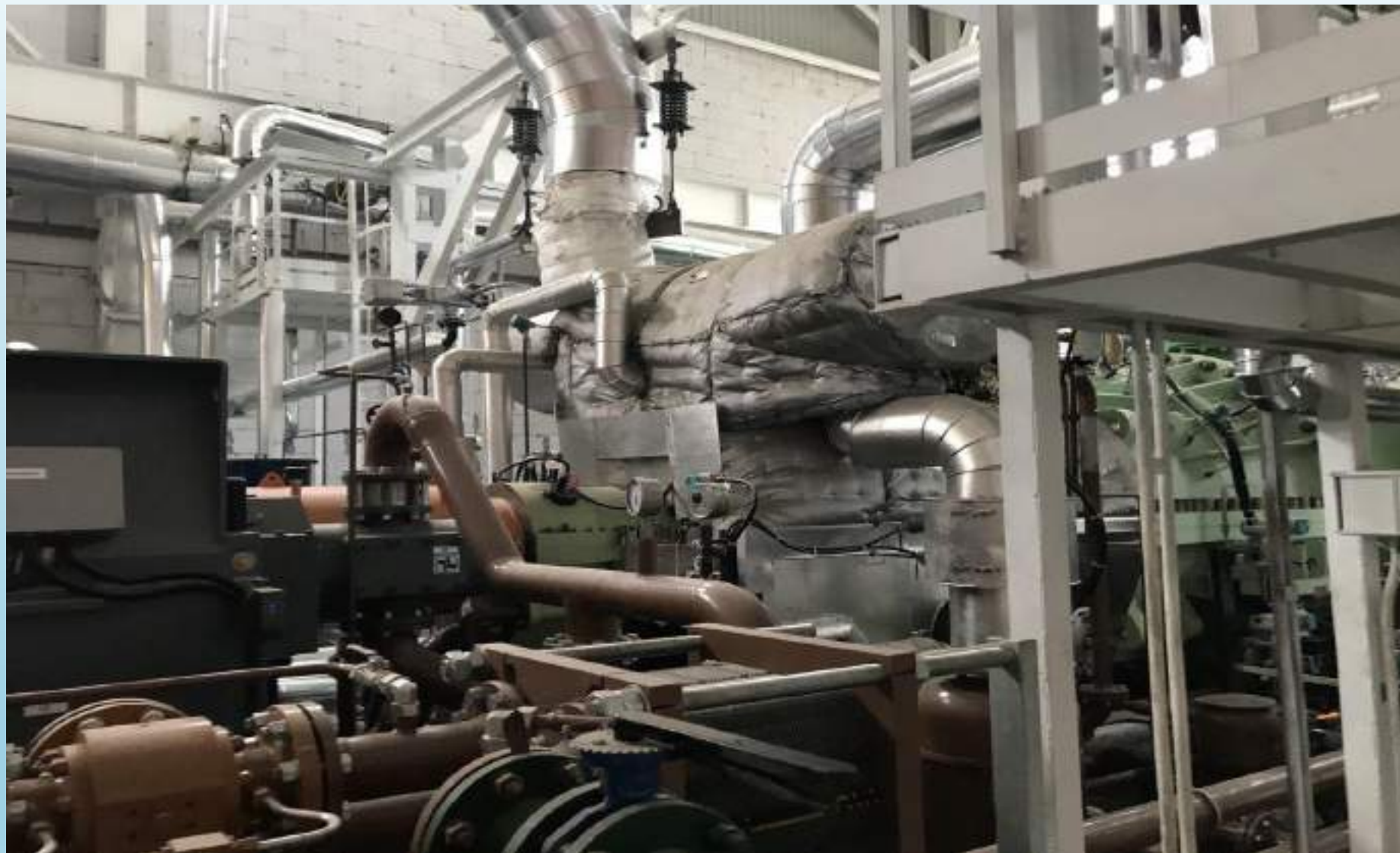
Осень 2019 года монтаж турбинного зала
